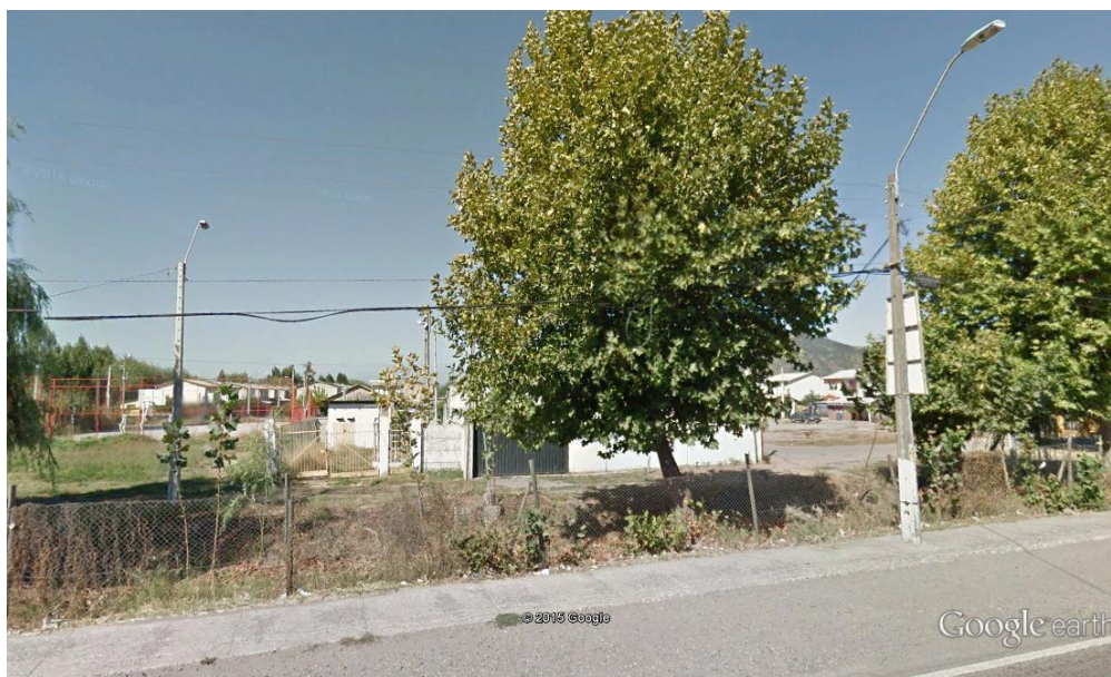
Figura 6. Planta Elevadora de Aguas Servidas Salvador Allende.
