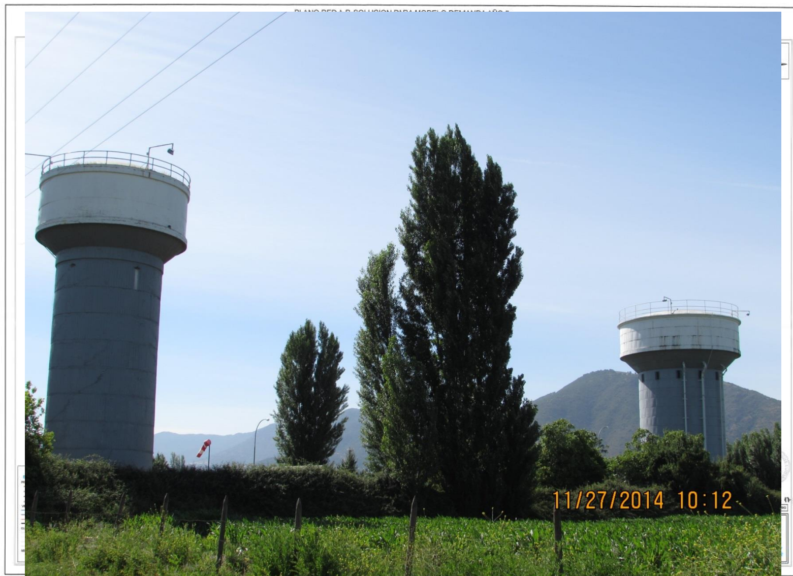
Figura 2. Estanques de Agua Potable de Nancagua
