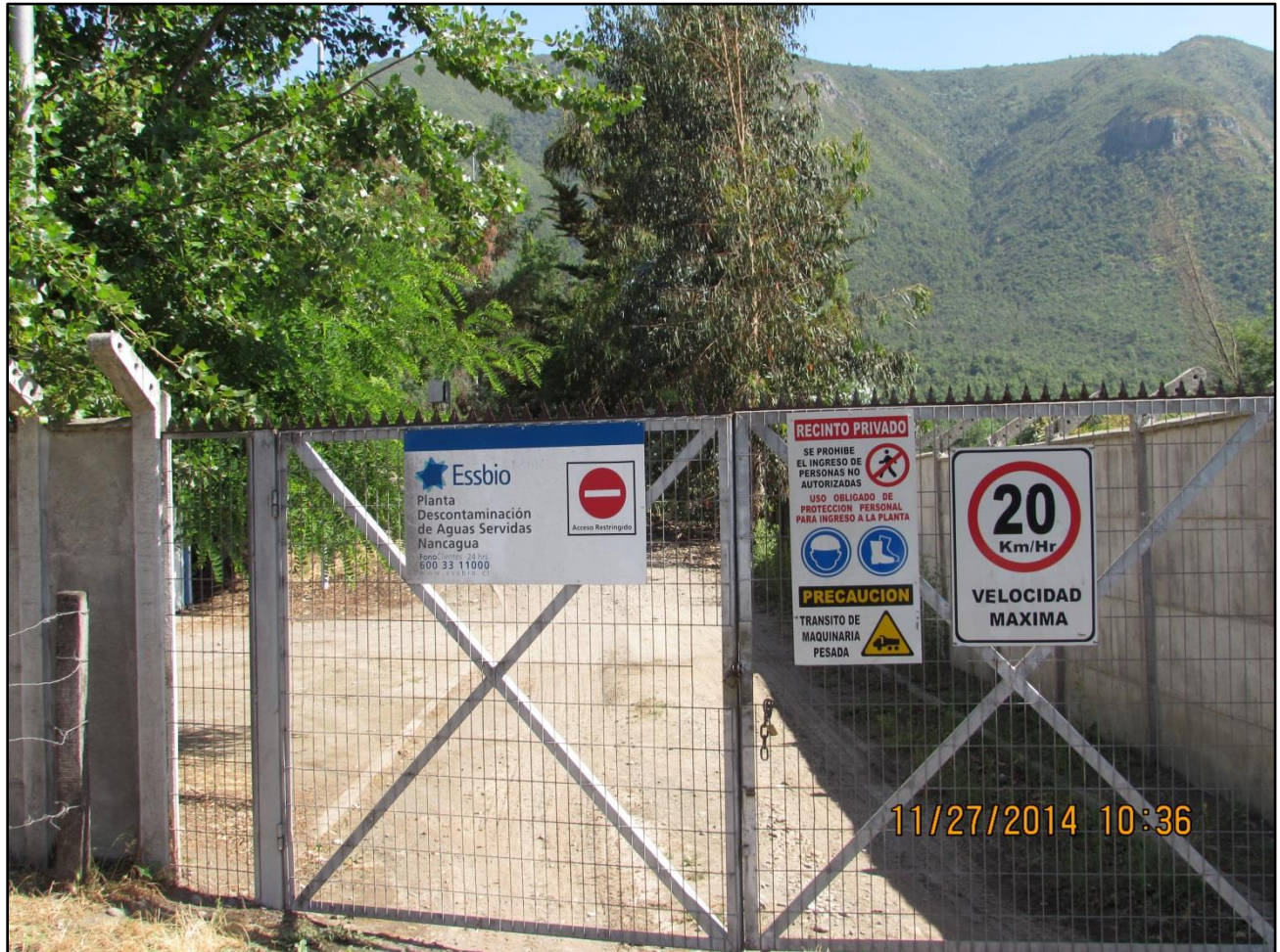
Figura 8. Planta de Tratamiento de Aguas Servidas Nancagua.
